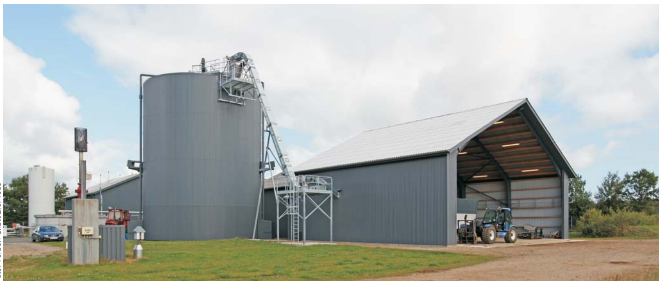
Biogasanlægget i Foulum får dagligt tilført op mod fire tons briketteret halm/tørt græs. Briketteringen medfører et øget gasudbytte på omkring 35 procent i forhold til ubehandlet biomasse.
